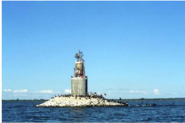
Rysunek 55. Stawa – znak nawigacyjny lub sygnalizacyjny umieszczony w sposób stały (wbity dno, bez użycia kotwicy), na brzegu lub na morzu.
